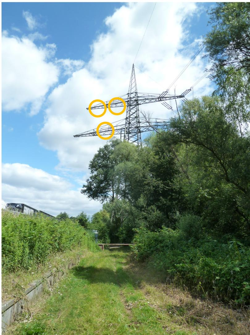
**Abbildung 16** *Stromkreisführung auf Anlage 7570 bei Mast 025 (freier Platz für das Vorhaben orange)*
