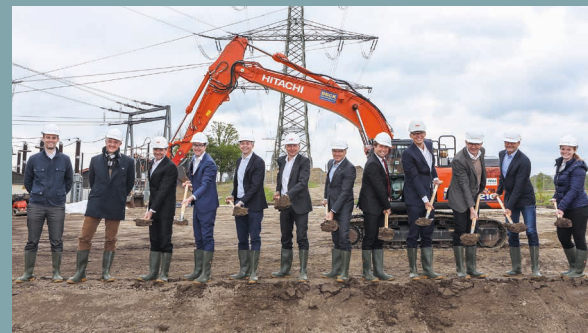
Spatenstich für den innovativen Umbau in Obermoosweiler
