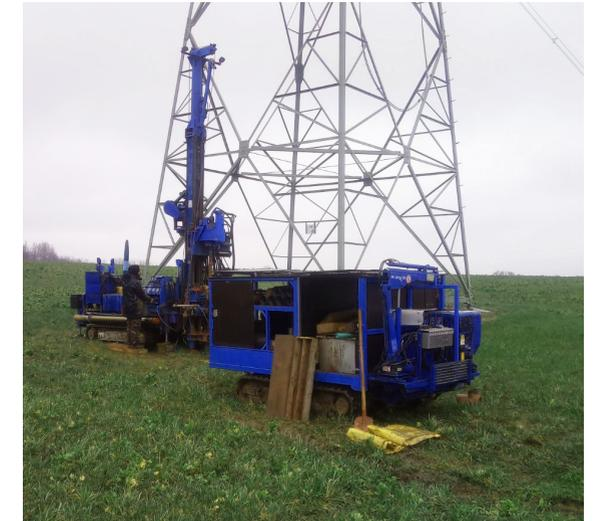
Mit dem Erreichen der Solltiefe erfolgt die meterweise Entnahme der Proben inklusive der Dokumentation, der schichtgerechten Rückverfüllung des Bohrguts und das Abdichten bindiger Schichten mittels Tonpellets/Bentonit.
