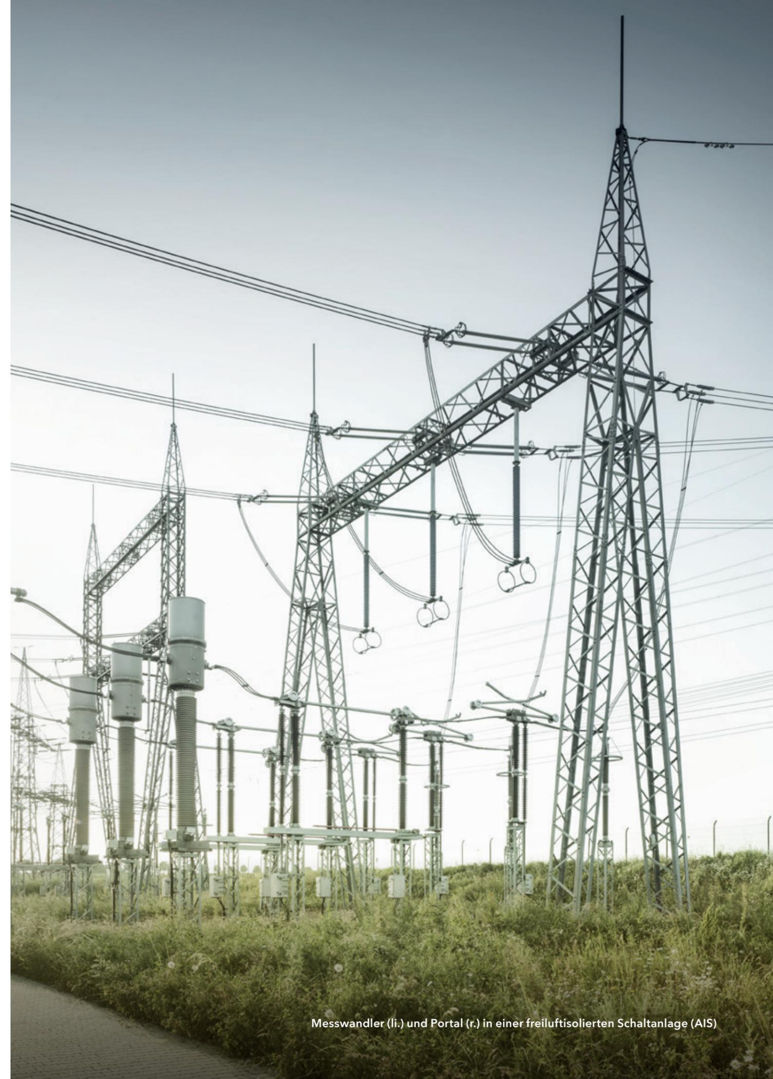
Messwandler (li.) und Portal (r.) in einer freiluftisolierten Schaltanlage (AIS)
