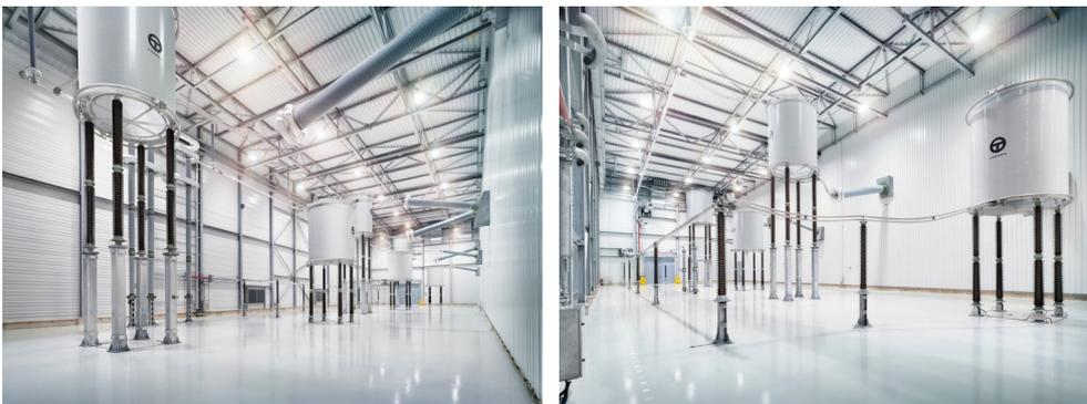
*Einblick in eine der vier Drosselhallen des Konverters. Hier wird zukünftig der Gleichstrom vor der Umwandlung in Wechselstrom verarbeitet.*
