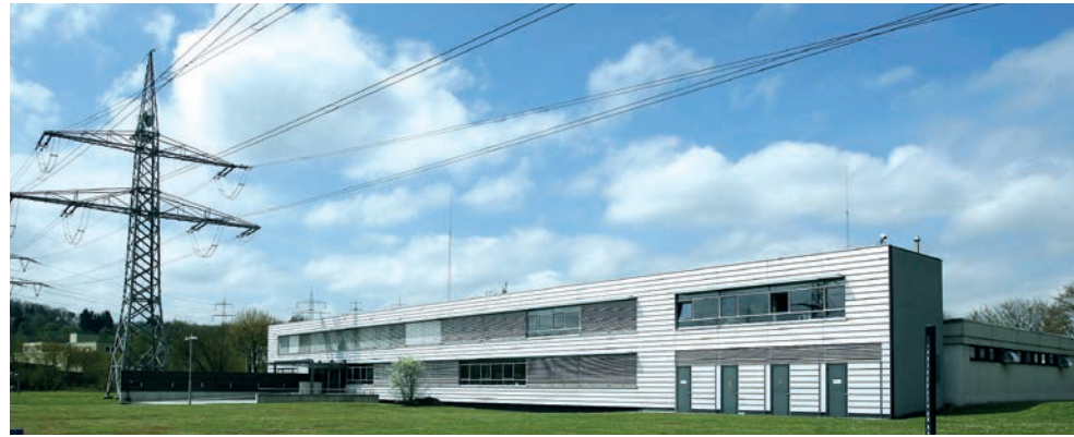
Das Herz unseres Versorgungsnetzes: die Hauptschaltleitung in Wendlingen.
