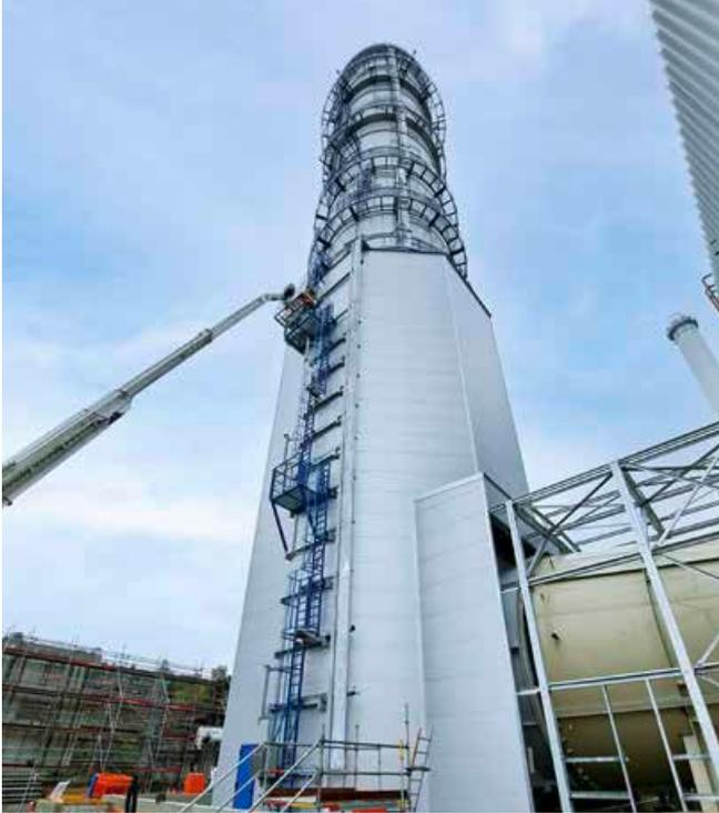
Die heißen Abgase aus der Turbine werden mittels eines Diffusors über einen 80 Meter hohen, separaten Schornstein abgeleitet.
