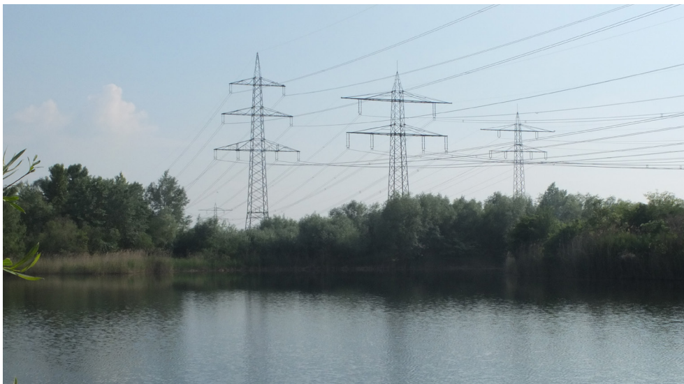
Blick nach Süden Richtung Oberhausen-Rheinhausen. Links im Bild die Bahnstromleitung, in der Mitte die 220-kV-Leitung der TransnetBW, rechts die 110-kV-Leitung der NetzeBW
