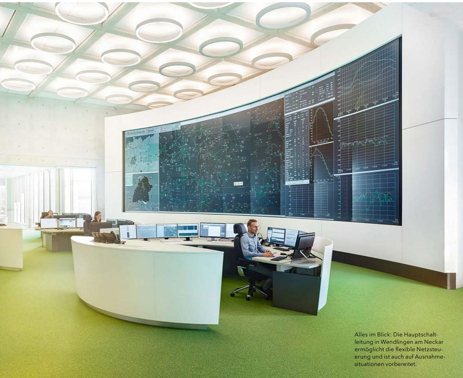
Alles im Blick: Die Hauptschaltleitung in Wendlingen am Neckar ermöglicht die flexible Netzsteuerung und ist auch auf Ausnahmesituationen vorbereitet.
