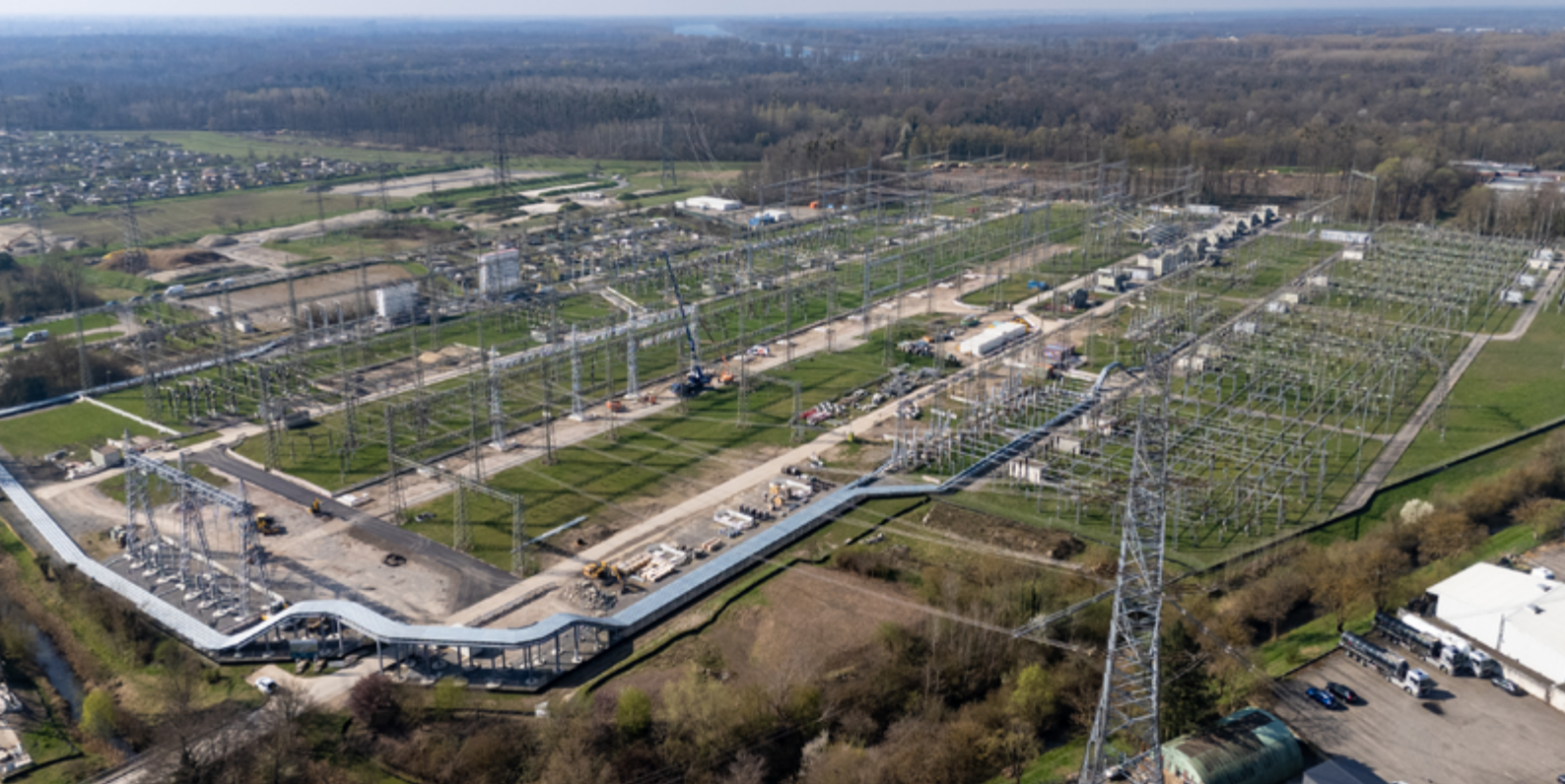
Drohnenaufnahme der Baustelle des Umspannwerks Daxlanden
