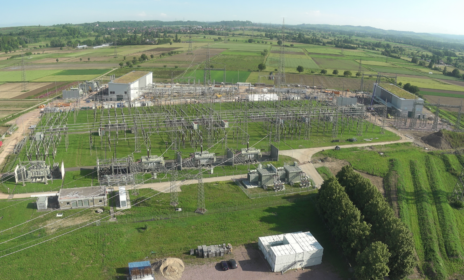
Drohnenaufnahme der Baustelle des Umspannwerks Eichstetten
