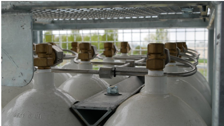
Abbildung 3.11: Niederdruckspeicher
