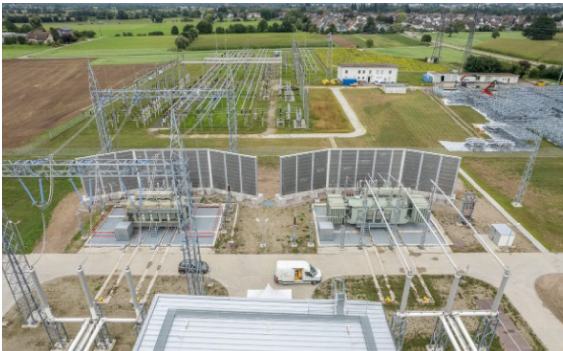
Das Umspannwerk Weier mit den zwei neuen Schallschutzwänden und der angrenzenden Anlage der Netze BW.
