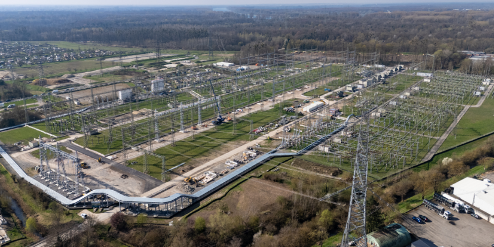
Drohnenaufnahme der Baustelle des Umspannwerks Daxlanden
