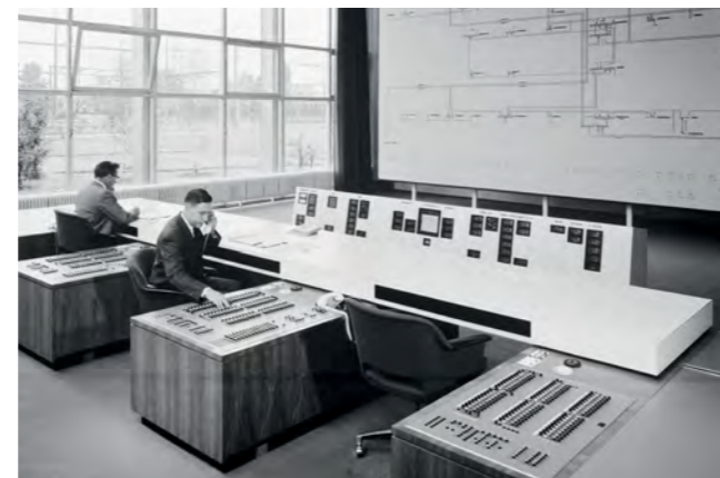
Mit freiem Blick auf das Umspannwerk: die neue Hauptschaltleitung in den frühen Sechzigern des letzten Jahrhunderts.
