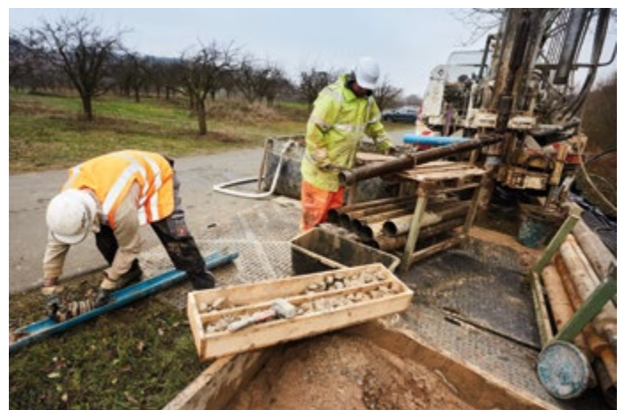
Die Methode der Baugrunduntersuchung hängt davon ab, welche Kennwerte wir benötigen und welche Voraussetzungen vor Ort bestehen.
