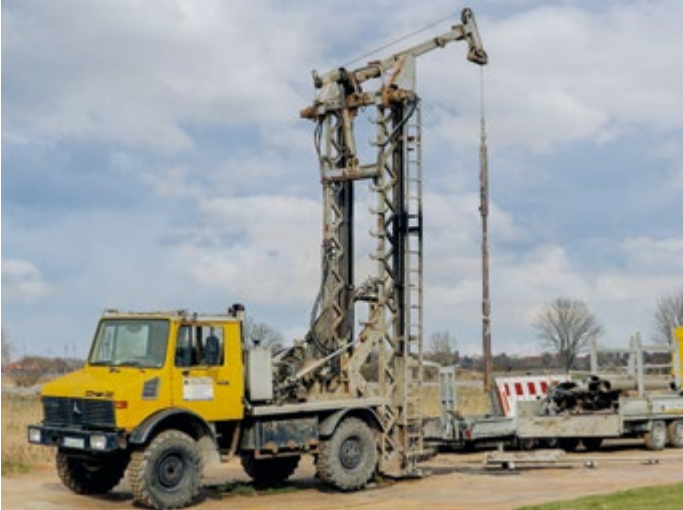
Ein Lkw bringt das Bohrgerät zur Baustelle.
