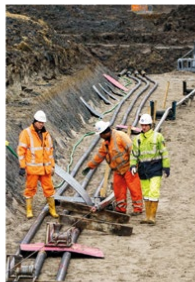
Baubegleitend: Bodenschutz bei der Bauausführung
