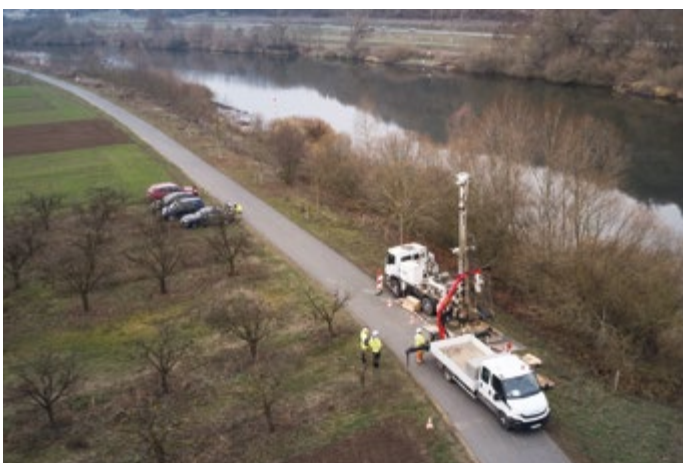
Baugrunduntersuchungen liefern wichtige Erkenntnisse für die Planung, den Bau und den Betrieb von SuedLink.
