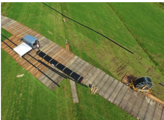
Bodenschutz mit Baggermatten aus Holz: Bei Bedarf werden flächendruckangepasste Geräte oder Baggermatten zum Schutz des Bodens eingesetzt.
