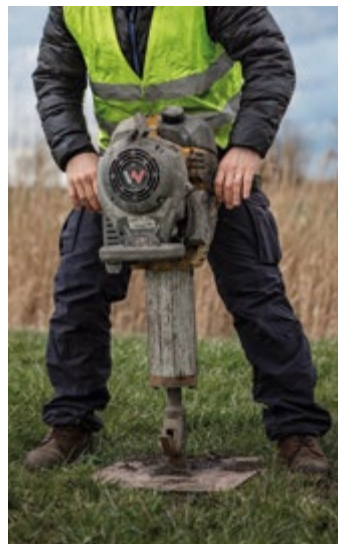
Ein Kleinrammbohrer kommt vor allem bei kleinen Sondierungen entlang der Regelstrecke zum Einsatz: Eine hohle Stahlsonde wird über einen darauf geschraubten Schlagbolzen mit einem Schlaggerät in den Boden gestemmt.
