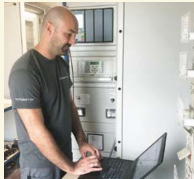
Thomas Merklinger, bei der Parametrierung von Schutzgeräten.
