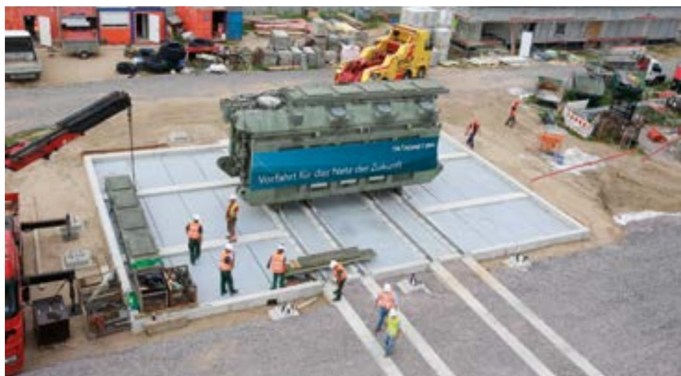
Trafo-Transport zum Umspannwerk Philippsburg - Altlußheim.
