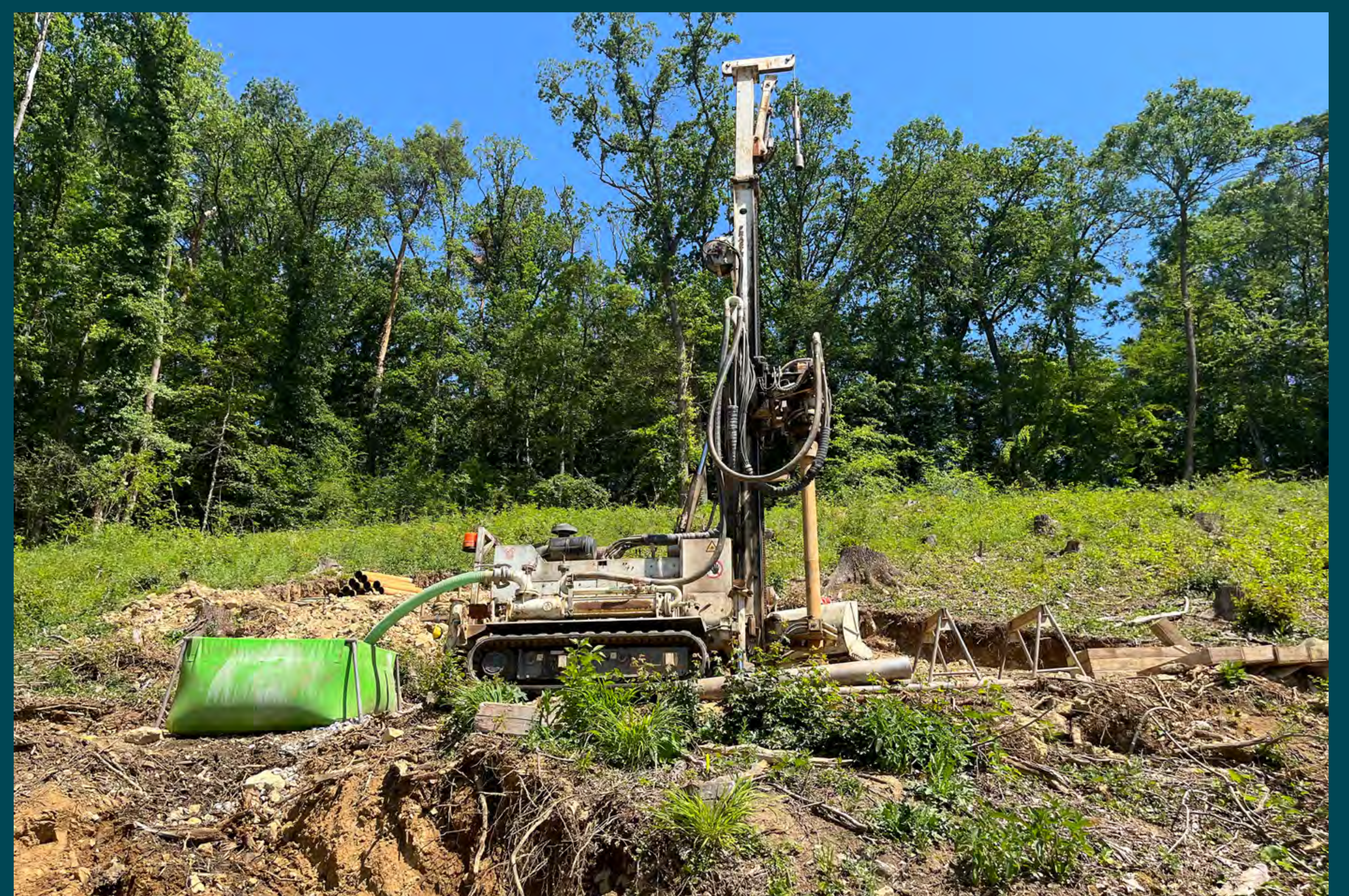
Zum Einsatz kommendes Gerät bei Rotationskernbohrungen
