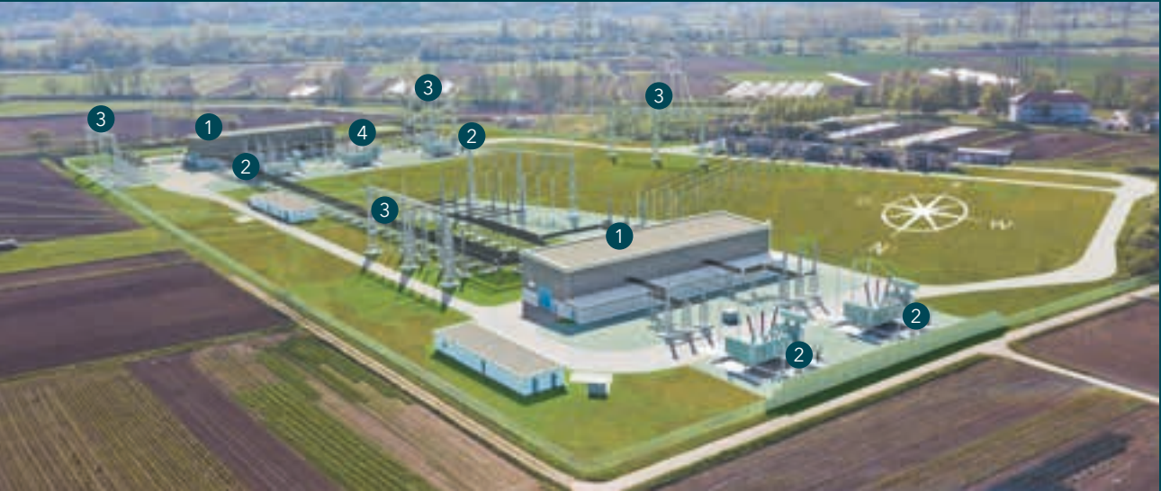
1 380-kV-Gasisolierte Schaltanlage 2 380-/110-kV-Transformatoren 3 380-kV-Freileitungsportale 4 380-kV-Kompensationsdrossel
