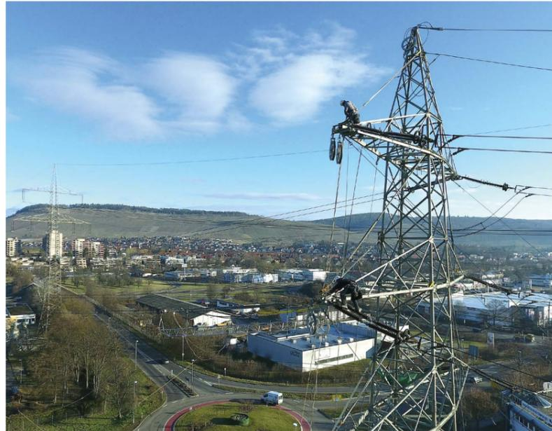
**R**und 80 Meter über der Erde laufen Monteure auf Traversen, Leiterseilen und Leitern hin und her und nehmen in luftiger Höhe Stromseile von Masten ab. Im Auftrag der TransnetBW bauen sie nach und nach insgesamt 70 Stromleitungsmasten zwischen Korb im Remstal und Wendlingen im Kreis Esslingen zurück. Die 220-Kilovolt-Leitung wird in diesem Abschnitt nicht mehr benötigt, da einzelne Leitungsabschnitte
