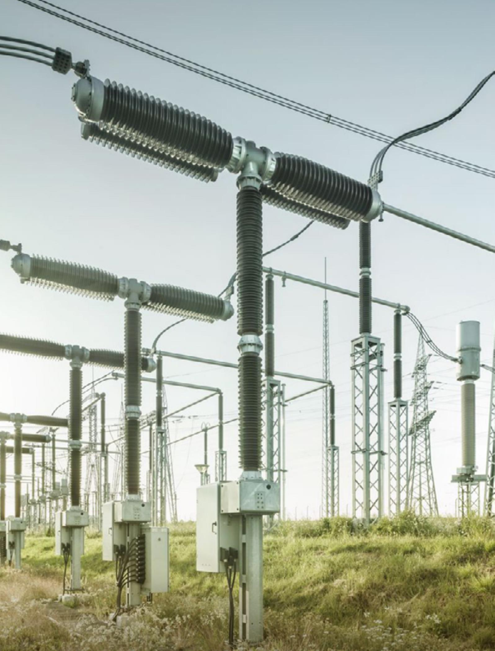
Leistungsschalter in einer freiluftisolierten Schaltanlage (AIS)
