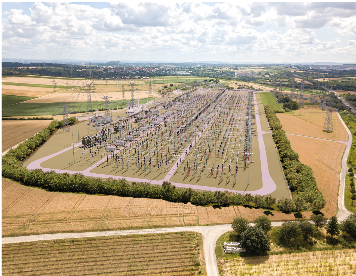
3D Visualisierung: Das erneuerte Umspannwerk aus der Vogelperspektive
