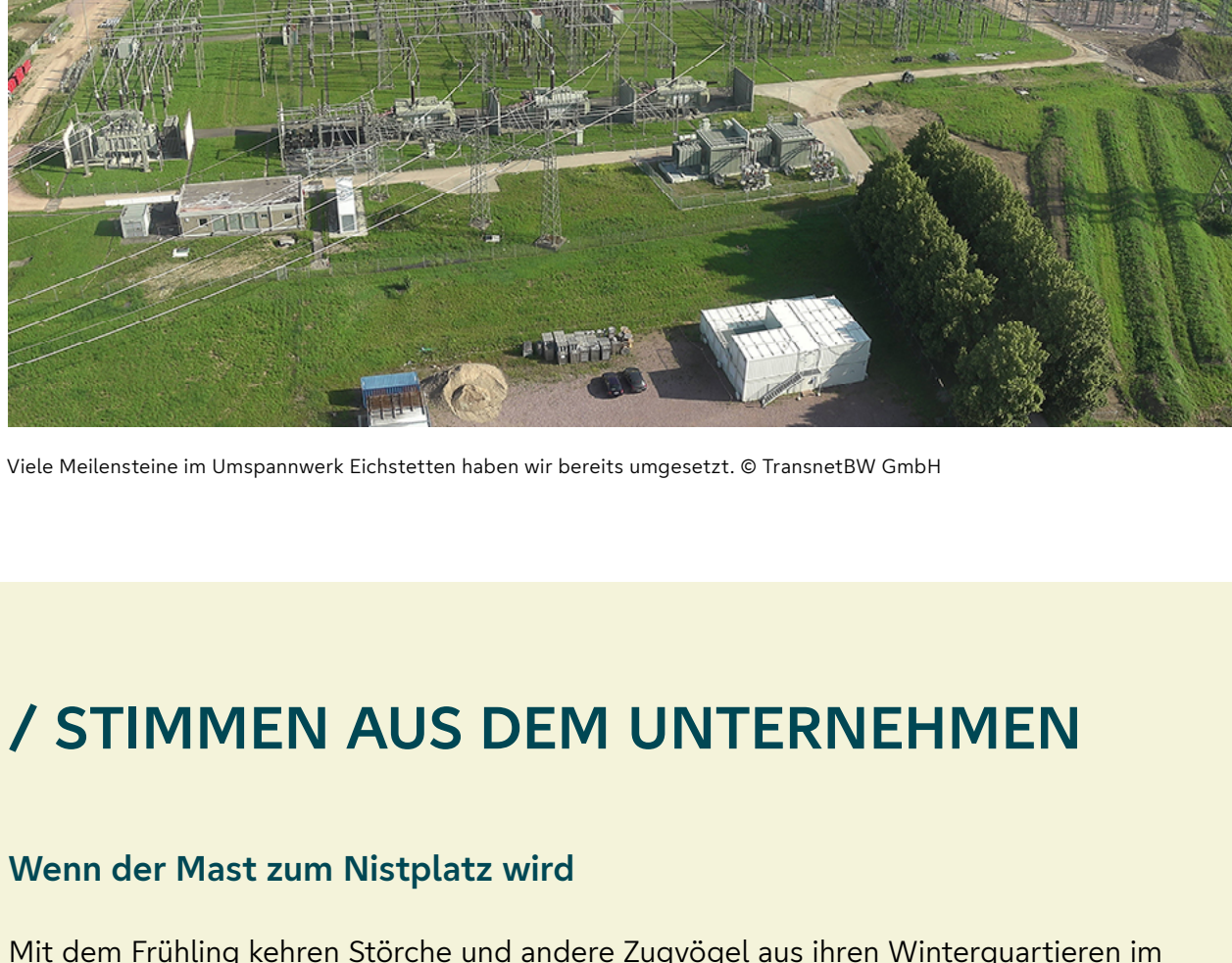
Viele Meilensteine im Umspannwerk Eichstetten haben wir bereits umgesetzt. © TransnetBW GmbH
