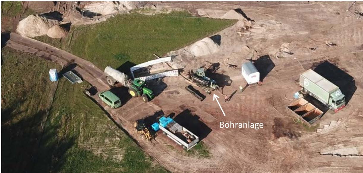
Abbildung 9: Baustelleneinrichtung Spülbohrverfahren HDD
