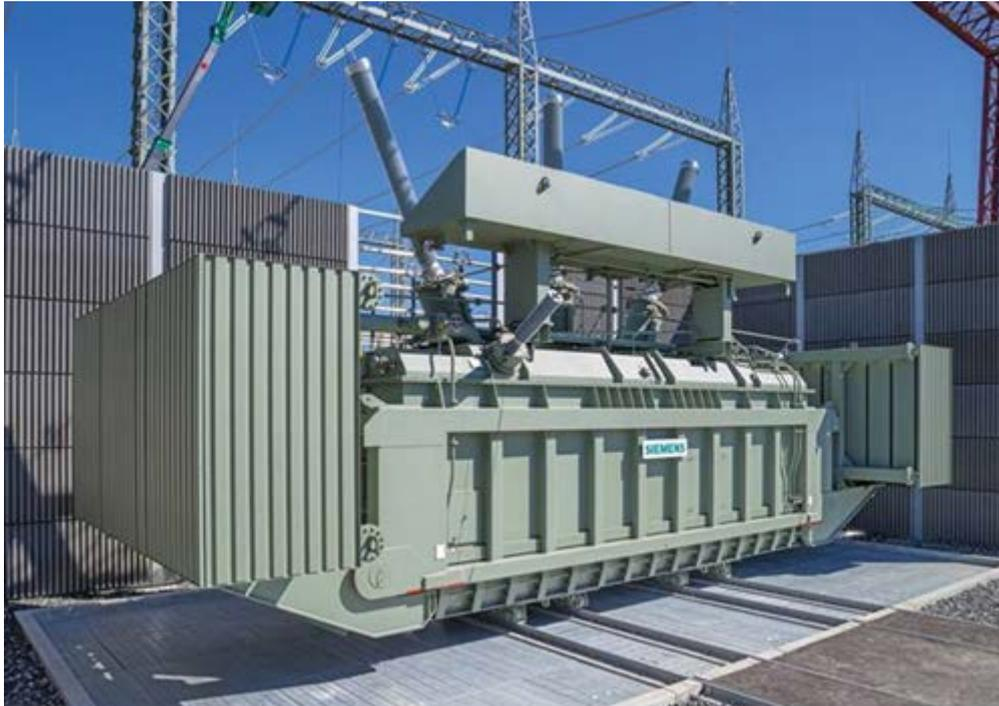
Abbildung 15: 250-MVAR-Drosselspule für die Blindleistungskompensation (Quelle: Siemens)
