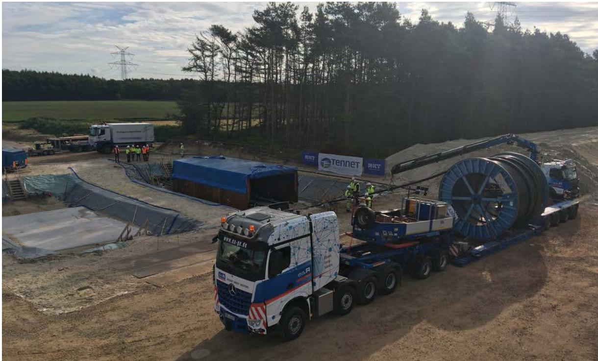
*Abbildung 7: Erdkabeleinzug vom Tieflader an einer Muffengrube*
