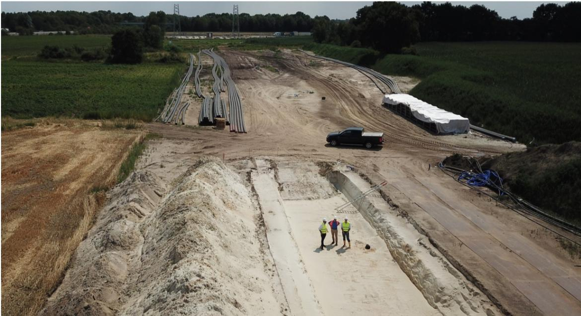
*Abbildung 4: Offener Erdkabelgraben im Projekt Dörpen - Niederrhein (TenneT)
