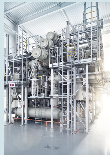
Gasisolierte Schaltanlage
