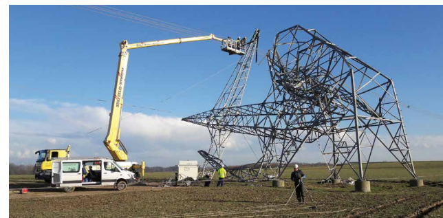
Die zerstörten Masten werden vollständig abgebaut und durch neue ersetzt. Bis zum Herbst 2018 sollen die Bauarbeiten abgeschlossen werden.
