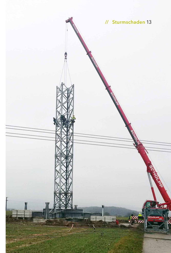
Stück für Stück nach oben: Beim sogenannten Stocken werden die einzelnen Elemente des Notgestänges aufeinandergesetzt und von einem Team sorgfältig verschraubt.
