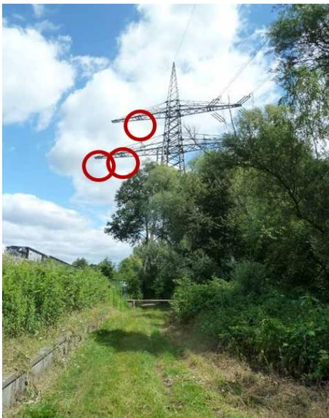
Südlich des Umspannwerks Neurott verläuft ULTRANET über ca. 22 km bis zum Gelände des Kernkraftwerks Philippsburg auf der Bestandsanlage 7570. Für ULTRANET können in diesem Abschnitt die auf der westlichen Mastseite liegenden freien Traversen auf der Bestandsanlage 7570 für die Zubeseilung genutzt werden (siehe Foto links). Es kann daher in diesem Abschnitt auf den Rückbau bestehender bzw. den Ersatzneubau neuer Masten verzichtet werden.
