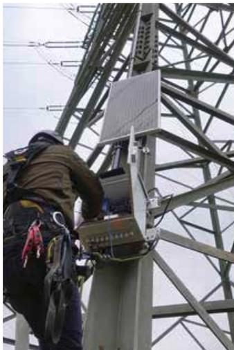
Die Wettermessgeräte am Mast werden über ein Solarpanel versorgt.
