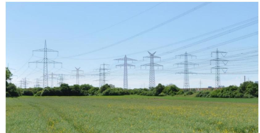
Westlich von Seckenheim werden eine 110-kV- und eine 220-kV-Leitungsanlage zurückgebaut und durch zwei neue Anlagen ersetzt. Auf der in der Visualisierung rechts dargestellten neuen Anlage wird ULTRANET verlaufen. Die links dargestellte neue Anlage wird die zuvor zurückgebaute 220-kV-Leitungsanlage ersetzen (Folgemaßnahme).
