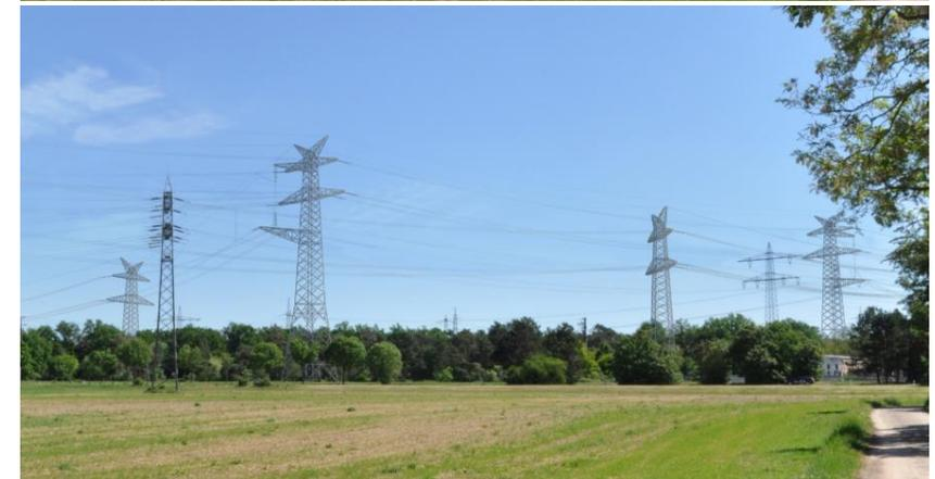
Südlich des Umspannwerks Rheinau wird der Verlauf der bestehenden 220-kV-Leitungsanlage geringfügig angepasst, um Platz für die neu hinzukommende ULTRANET-Leitung zu schaffen.
