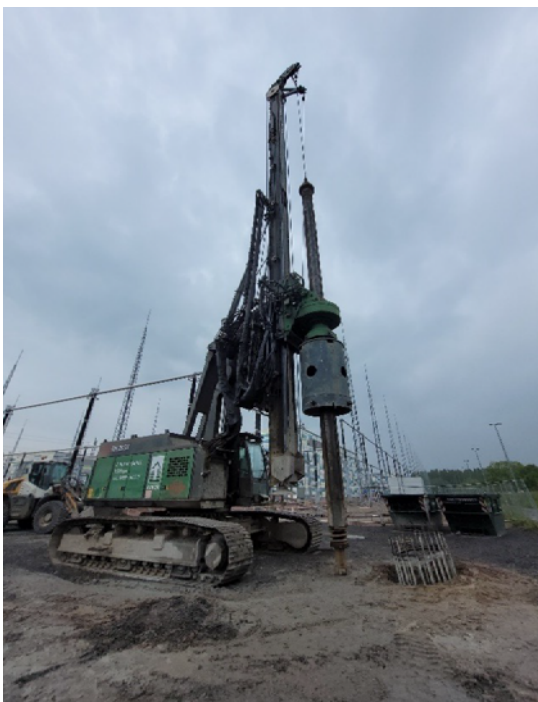
Die Bohrpfahlmaschine im Einsatz bei der Gründung der Bohrpfähle
