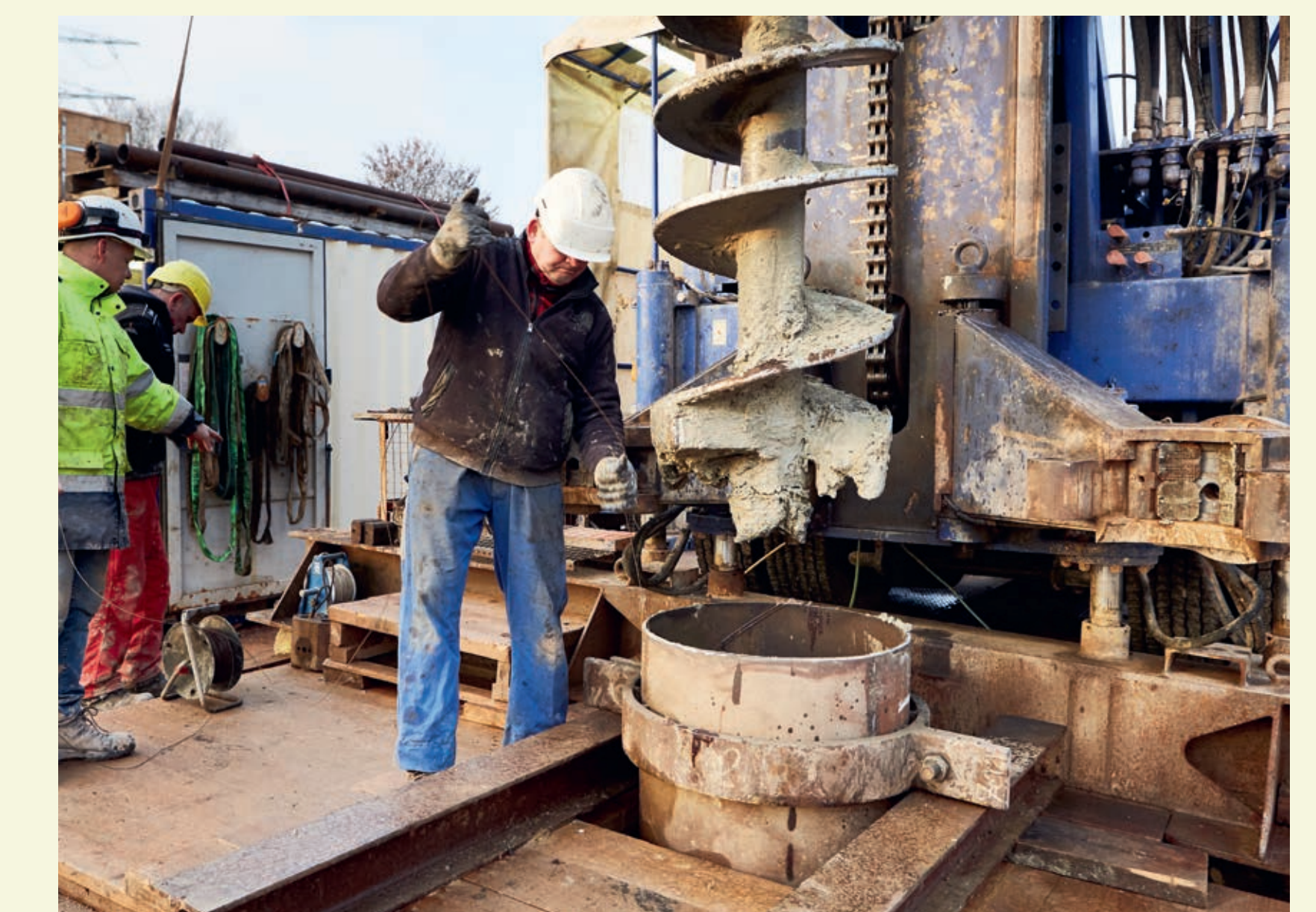
Arbeiten am Bohrloch
