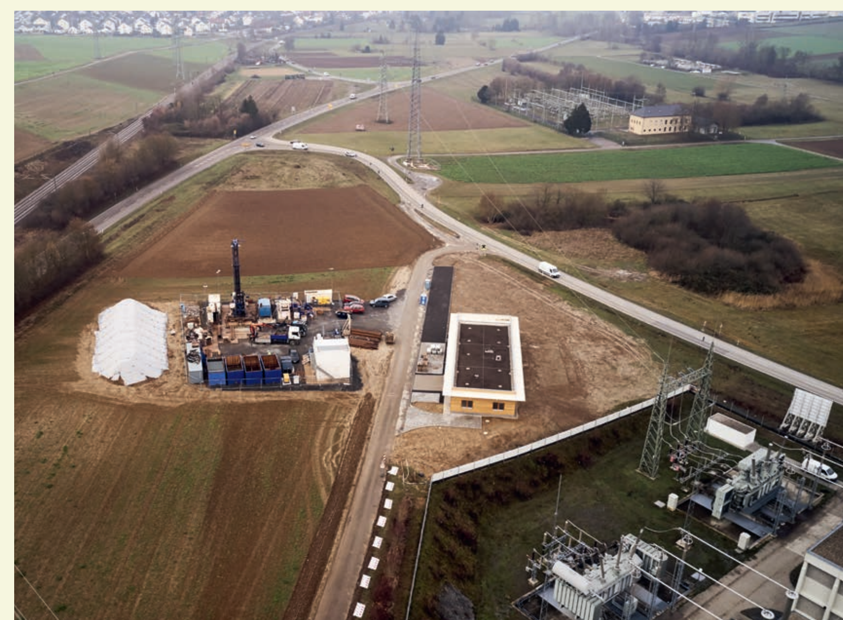
Gesamtansicht Bohrplatz in Leingarten; rechts im Bild: Infocenter sowie Umspannwerk
